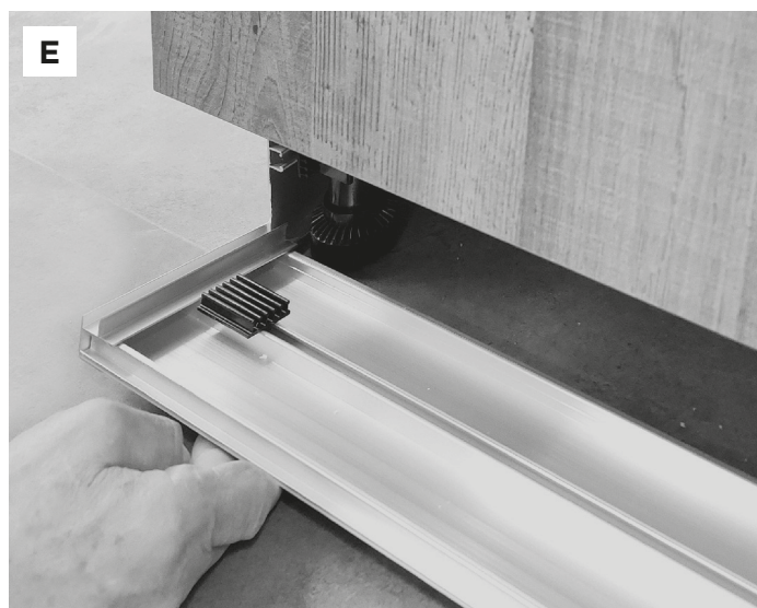
Aplicar los elementos de fijación en los zócalos laterales. Posicionar el zócalo en el suelo en la posición correcta y colocar los elementos de fijación delante de los soportes para el zócalo (C). Alzar el zócalo y enganchar los soportes con elementos de fijación.
